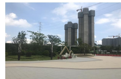
德威花园二期仿石砖现场实景
