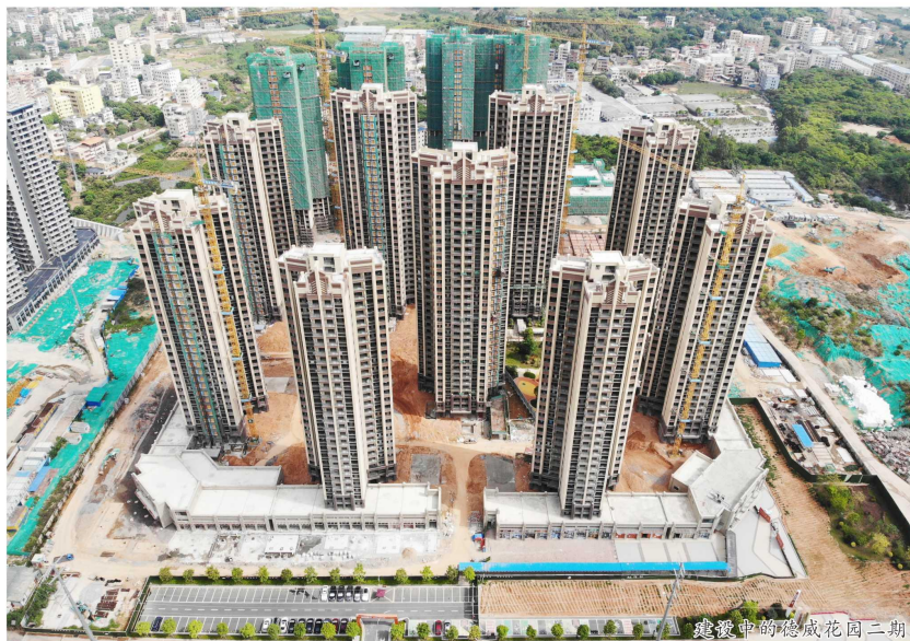
建设中的德威花园二期
